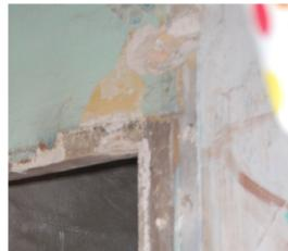
Figura 139 Vivienda de planta segunda. Papel pintado colocado sobre pintura anaranjada (Tordera, 2019)
