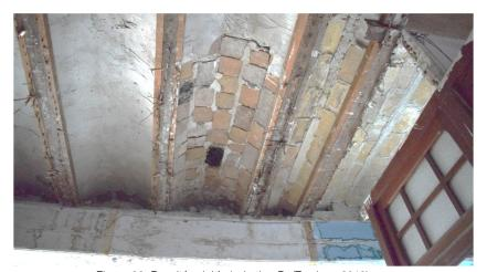
Figura 86: Revoltón del forjado tipo B. (Tordera, 2019)
