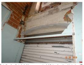
Figura 167: Detalle de dintel del hueco central. Vista desde el interior (Tordera, 2019)
