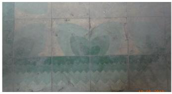
Figura 129 Alformbra de pavimento hidraulico (Tordera 2019)
