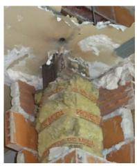
Figura 76 Detalle de soporte metálico (Tordera, 2019)
