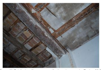
Figura 124 Detalle de cañizo en separación de cocina-comedor (Tordera 2019)
