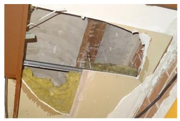
Figura 80. Viguetas. Forjado tipo B (Tordera, 2019)
