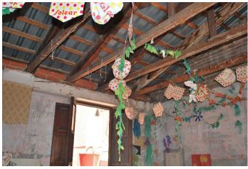
Figura 105: Estructura para el falso techo. Cubierta tipo B.01 (Tordera, 2019)
