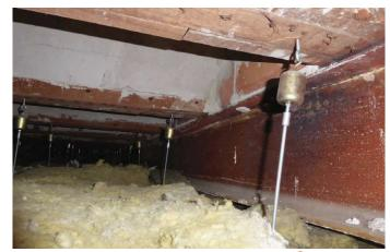
Figura 79: Viga metálica en segunda crujía. Forjado Tipo B cil<mark>i</mark>tada Facilitada por el propietario)
