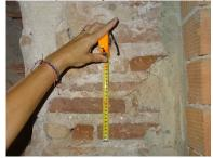
Figura 119: Imagen que muestra la métrica de la fábrica
