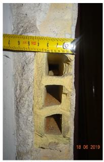
Figura 120. Restos de tabiquería en la planta primera destinada a vivienda
