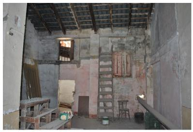
Figura 140: Espacio de actores. Se observa la decoración de pintura en fachada, así como la existencia de una naya para aprovechar la altura, que además cuenta con ventilación mediante ventana. (Tordera, 2019)
