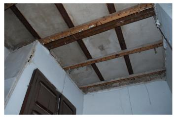
Figura 125: Detalle de estructura para el falso techo en la entrada (Tordera 2019)
