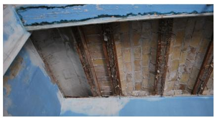
Figura 87: Revoltón resuelto con 5 rasillas. (Tordera, 2019)
