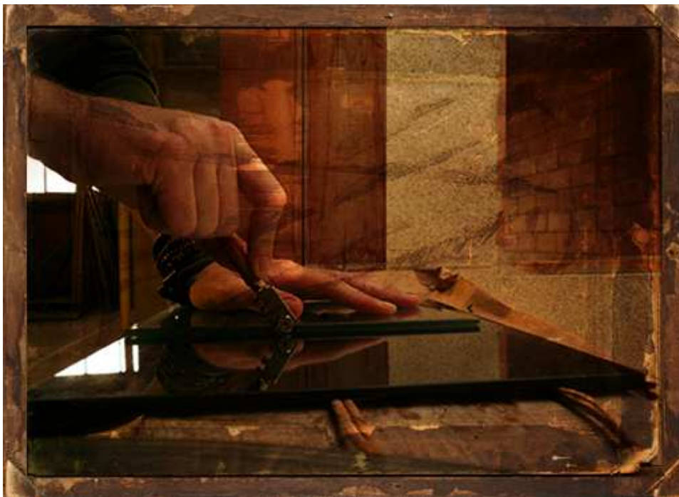
Figura nº 36: Cortando espejo (Construcción)
