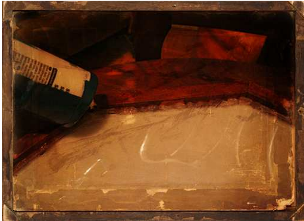
Figura nº 49: Aplicando silicona – parte interior (Seguridad)
