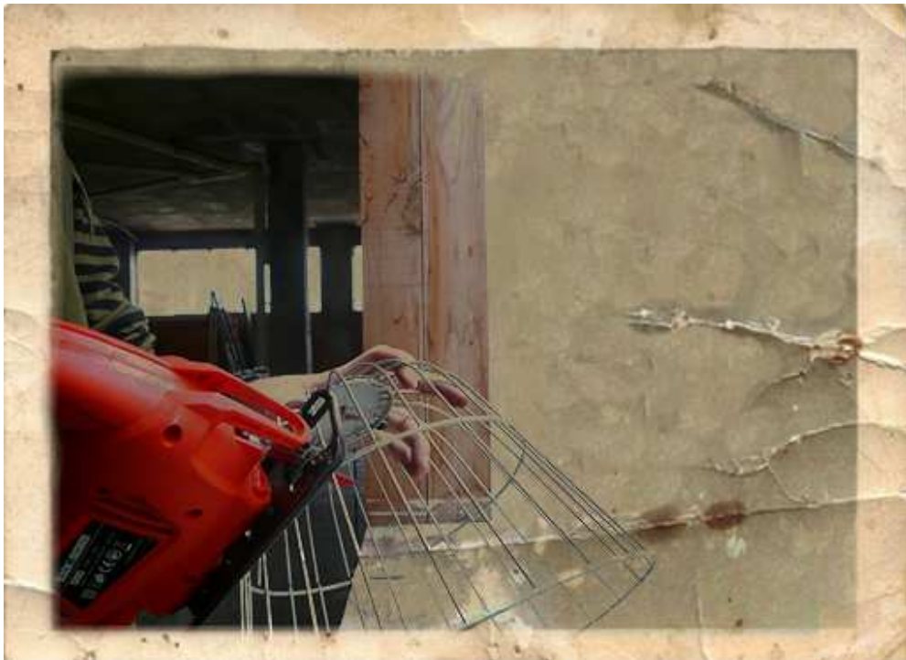
Figura nº 42: Cortando jaula con caladora (Pruebas de construcción)
