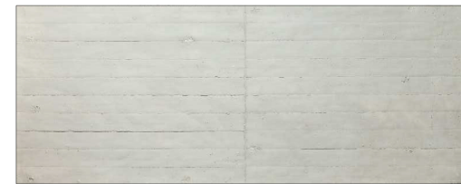
TECHO LOSA HORMIGÓN
