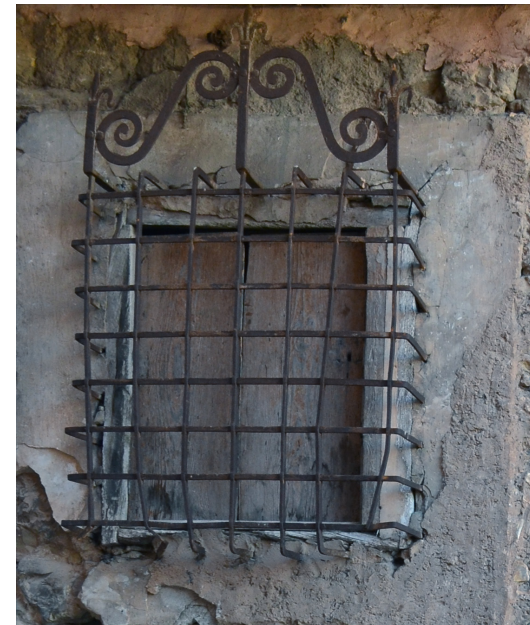
Figura 32. Imagen de deformaciones en una reja. Fuente: Raquel Asensio Lozano.
