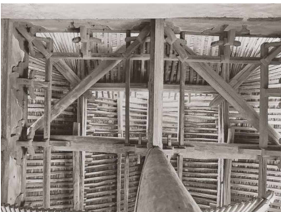
Fig. 35| Interior de cubierta, uso de distintos tipos de madera Fuente: Zwerger, K., Olgiatei, V. (2012) Wood and Wood Joints : Building Traditions of Europe, Japan and China
