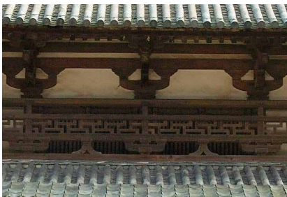
Fig. 19| Detalle del hijiki de la planta inferior Fuente: http://cort.as/-ME9J
