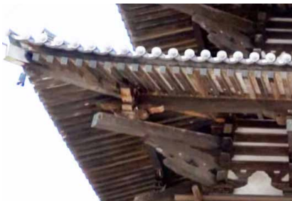
Fig. 18| Detalle del hijiki de las plantas superiores Fuente: http://cort.as/-ME9J
