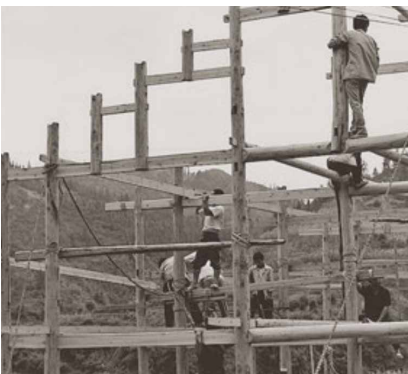
Fig. 39| Estructura en construcción, método chuandou Fuente: Zwerger, K., Olgiate, V. (2012) Wood and Wood Joints : Building Traditions of Europe, Japan and China
