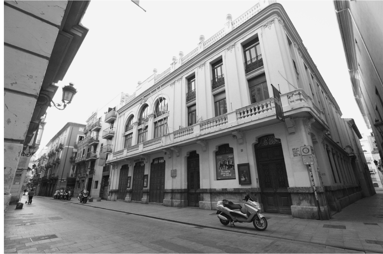
fig. 37 Fachada Principal Teatro Talía. Fuente: elaboración propia
