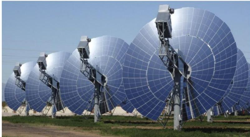
Figura 13. Central de discos parabólicos. (Fuente: [37]).
