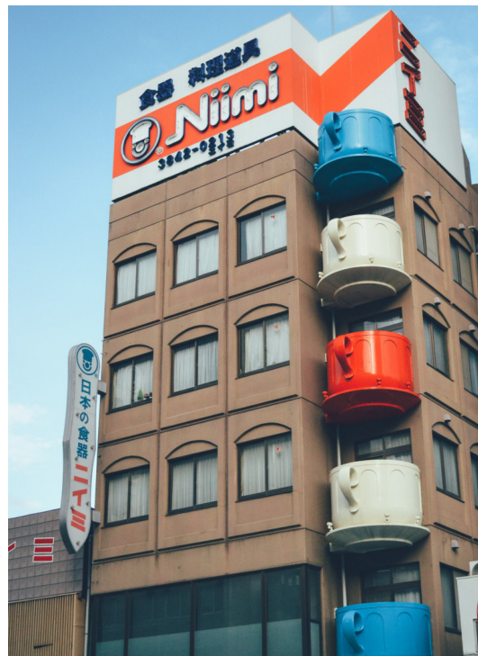
Fig. 4 Edifici del carrer Kappabashi (Japó).
