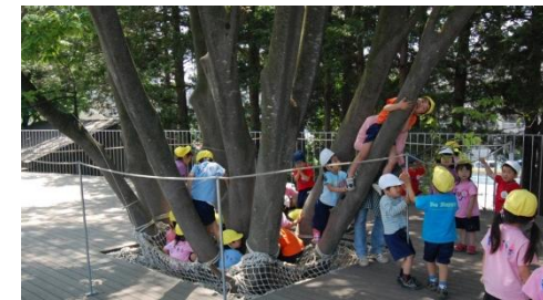
Fig.67. Imagen de referencia. Cubierta del Jardín de Infancia Tachikwa, Tokio, Japón, Arquitectos Fuji Takaharu y Yui Tezuka, 2007
