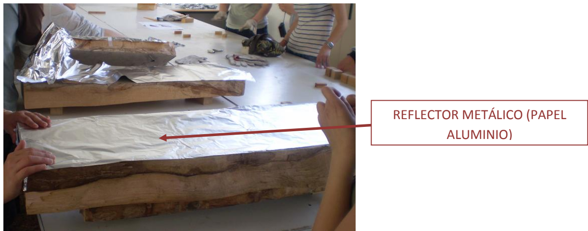
Figura 4.10 Colocación reflector metálico
