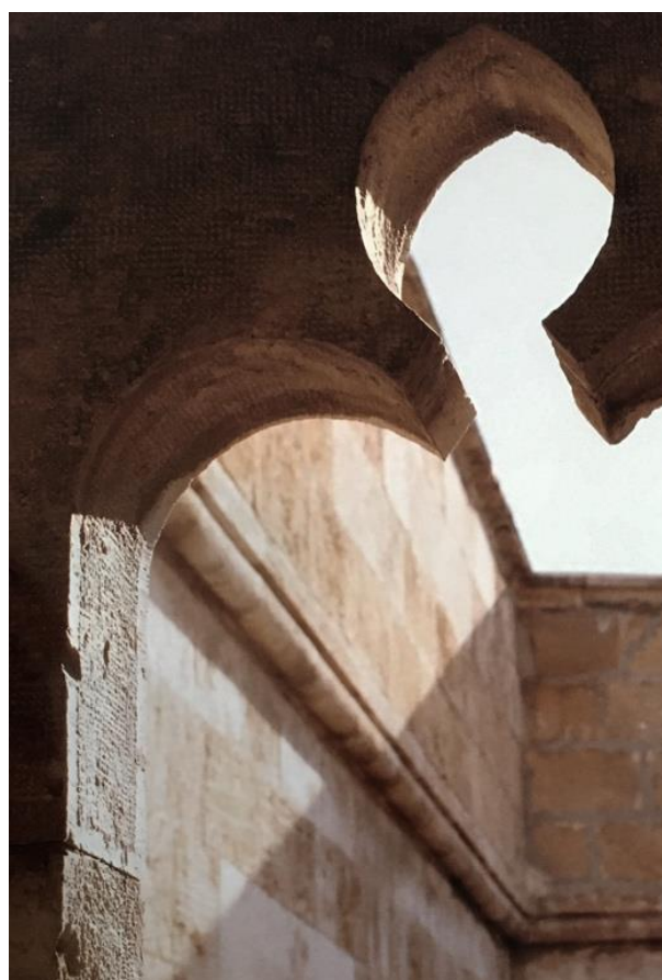
Figura 14: Detalle donde se perciben los cantos de la sillería, pulidos, tal como lo dispuso Gómez Davó. Foto del autor.
