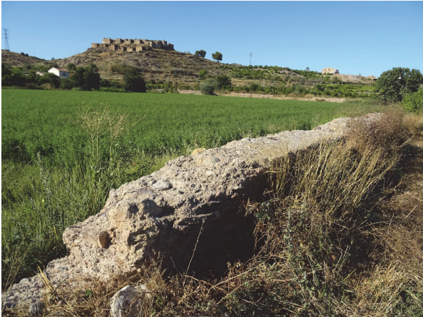
Figura 2. En primer plano restos del muro del albercón en las proximidades del Castillejo, ubicado al fondo de la fotografía.
