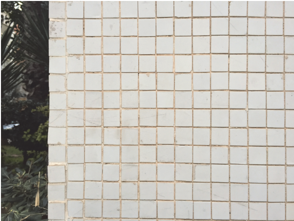
Figura 16. Detalle de la disposición de teselas de gres Nolla del Grupo Oikos en Álvaro de Bazán, 1-3-5, 1963.
