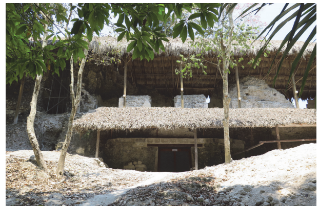
Figura 3. Exterior del Cuarto 1 del edificio 6J2 Sub. A. Aliperta 2016.
