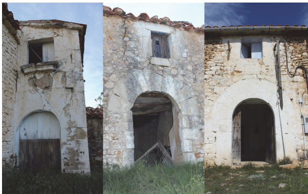
Figura 10. Detalle de trabajo de cantería en fachadas de masos documentados en 1530 y 1615. Fuente propia.
