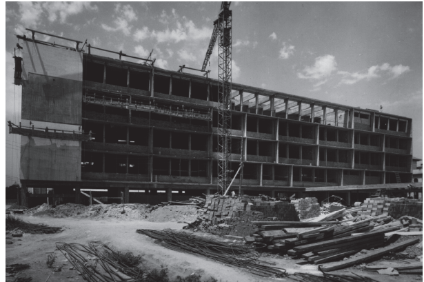
Figura 11. Arriba a la izquierda se aprecia la colocación del revestimiento de parte de la fachada en Nolla blanco mate (1960).
