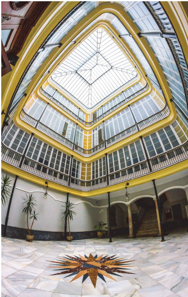
Fig. 5. Montera acristalada en patio interior de Casa Palacio.
