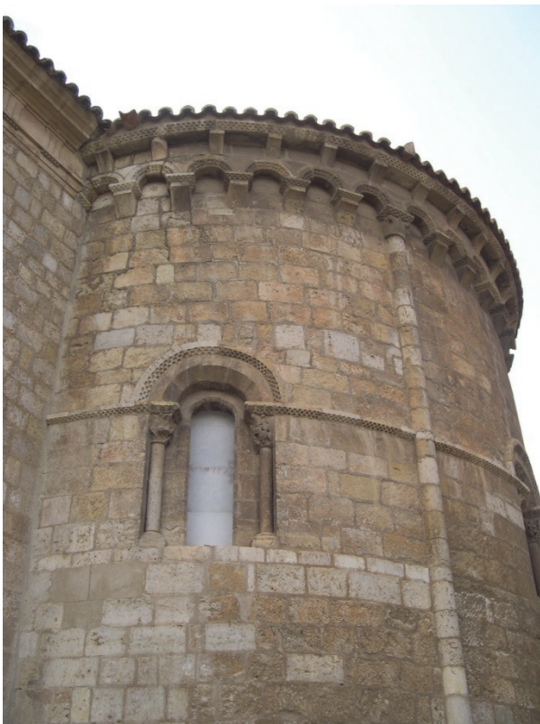
Figura 3. Ábside de la iglesia románica
