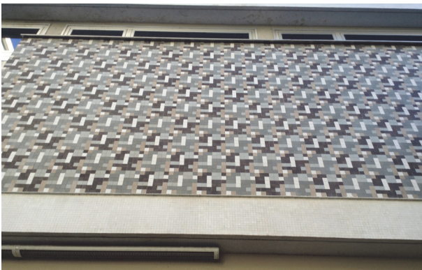
Figura 10. Imagen del exterior del edificio donde se aprecia la colocación de los módulos que componen los antepechos (2014).
