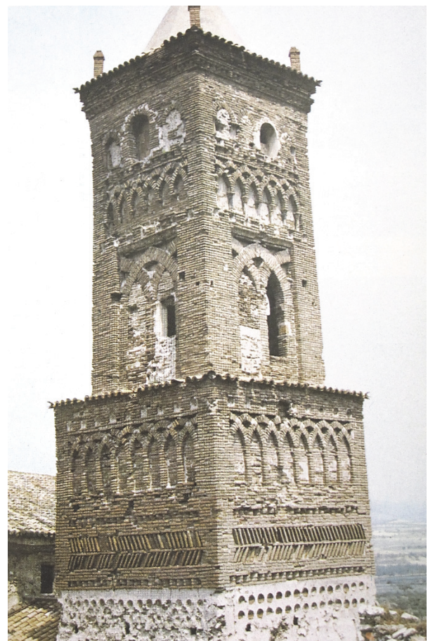
Figura 3. Torre de San Miguel en Belmonte antes de ser intervenida.
