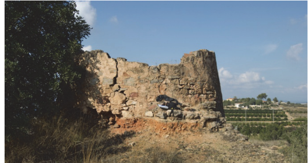
Figura 5. Parte alta del horno por la que se hace el llenado de la piedra caliza
