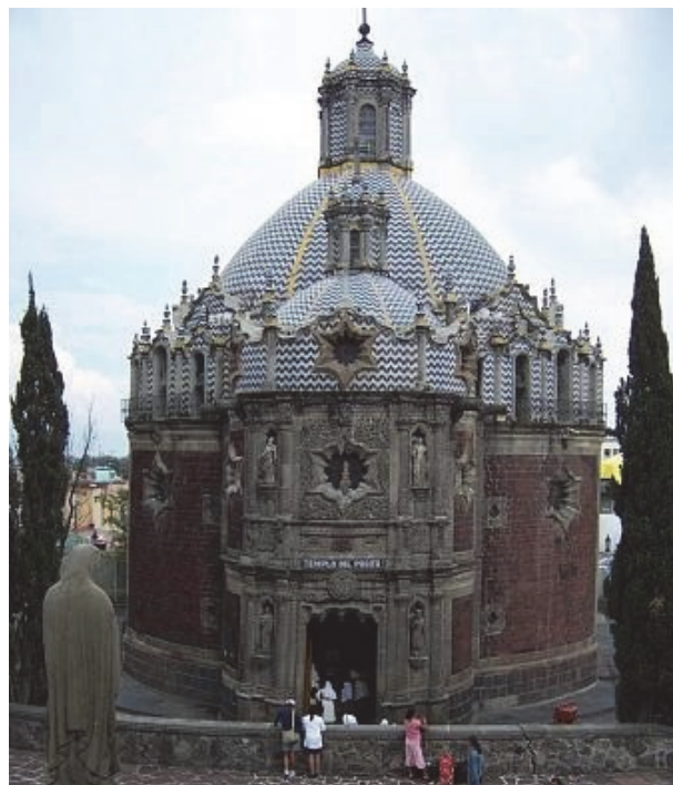
Figura 7. Fotografía de la fachada principal.
