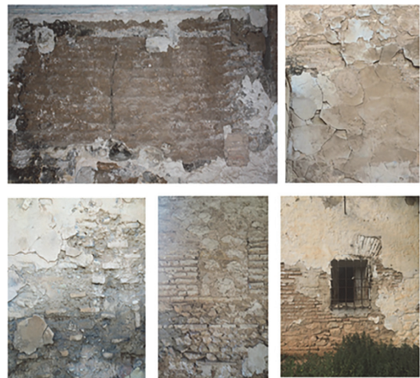
Figura 4. Tipologías murarias de la Alquería. Realización propia.
