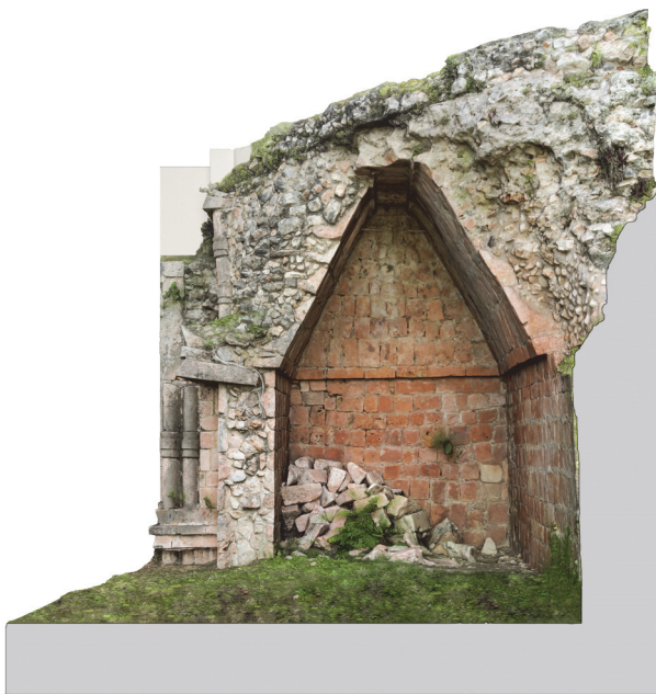
Figura 2. Modelo 3D del cuarto 7 de la Estructura 1 de Chacmultún.
