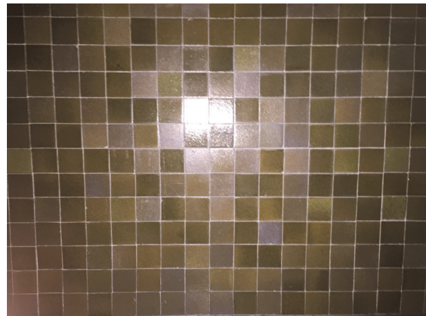
Figura 19. Forjado inferior del acceso revestido en gres Nolla, en el edificio de Jaime Roig 19, 1964.
