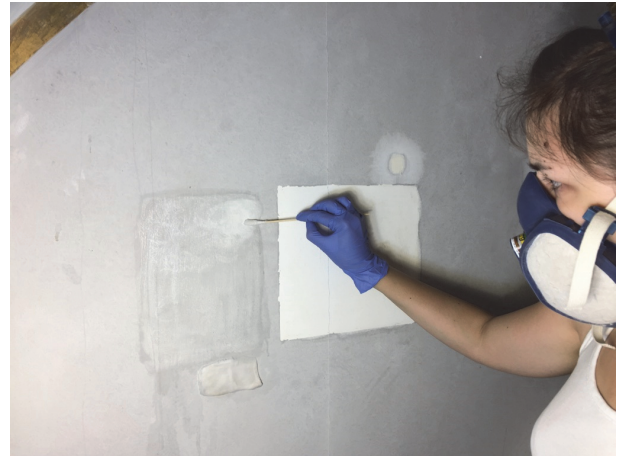
Figura 4. Testado de diversas microemulsiones y soluciones micelares para retirar las capas de pintura vinílica sobre los estucos que decoran las paredes de la Capilla de la Comunión de la Iglesia de San Nicolás en Valencia.
