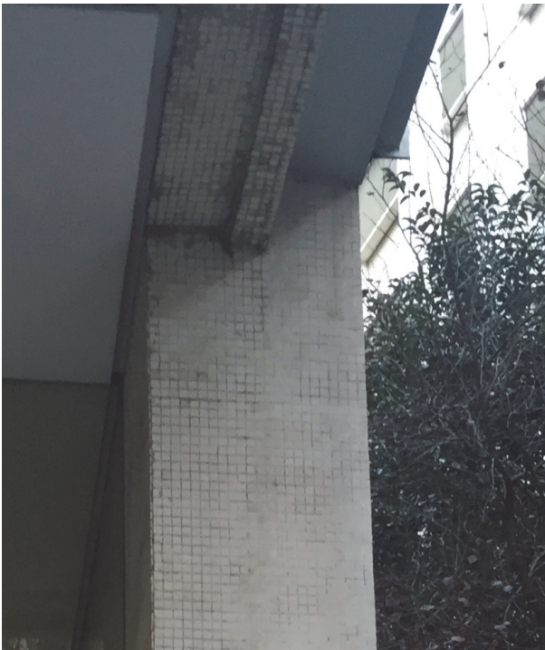
Figura 17. Detalle del revestimiento de gres Nolla del Instituto de Agroquímica y Tecnología de Alimentos, en Jaime Roig 11, 1964.
