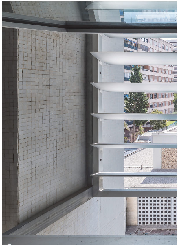
Figura 12. Imagen de los brise-soleil revestidos en Nolla blanco mate, vistos desde dentro de las aulas. Germán Cabo (2015).
