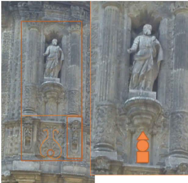
Figura 17. Lado norte del cuerpo superior de la fachada principal.
