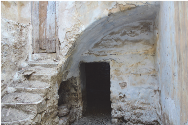
Figura 7. Escalera de sillares y bóveda de piedra en vivienda documentada en el siglo XIII. Fuente propia.
