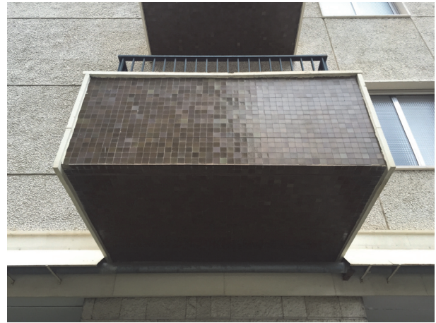
Figura 18. Antepecho y forjado inferior de balcón revestido en gres Nolla, en el edificio de Jaime Roig 19, 1964.
