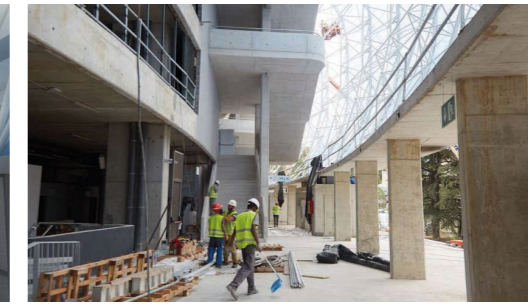
Fig. 65 Hall d'accés al camp en fase de construcció
