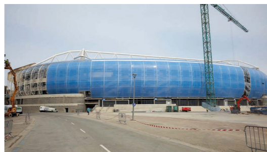
Fig. 70 Exterior de l'Anoeta en fase de construcció
