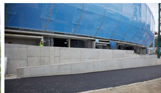
Fig. 63 Nou sòcol en fase de construcció
