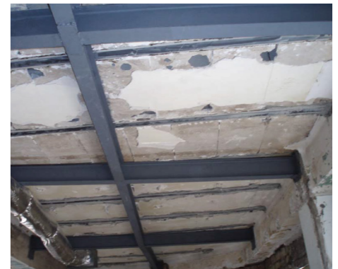
Figura 43. Refuerzo de viguetas y disposición de parteluz. Vivienda puerta número 15.
