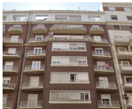
Figura 9. Edificio para la Caja de Ahorros y el Monte de Piedad, avenida Barón de Cárcer. Año 1955
