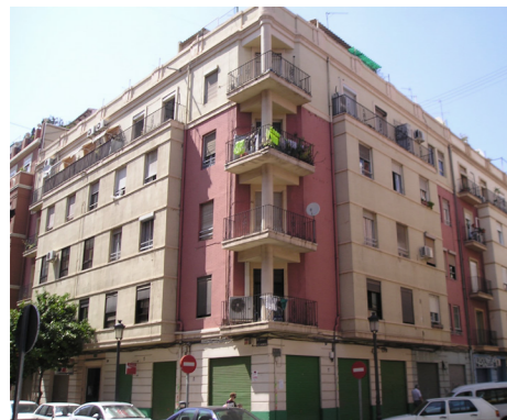
Figura 14. Fachadas principales edificio, calle Poeta Monmeneu 10.
