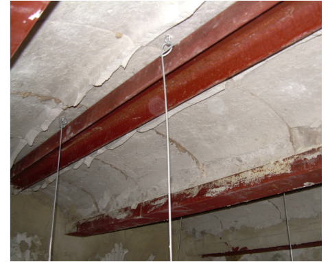
Figura 42. Refuerzo con perfilera metálica en cocina. Vivienda puerta número 14.
