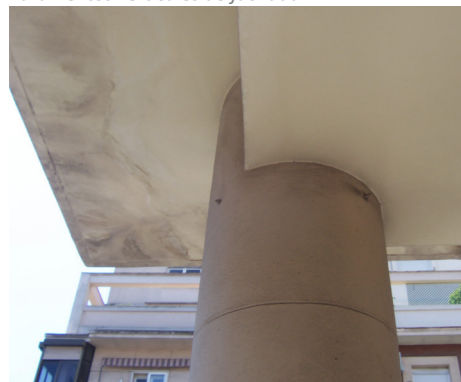
Figura 16. Patologías de lavado superficial sucio y eflorescencias o salitre. Cara inferior de mirador.
