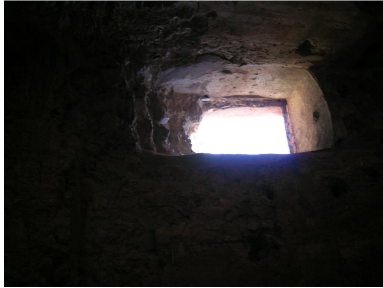
Fotografía interior de ventana.
