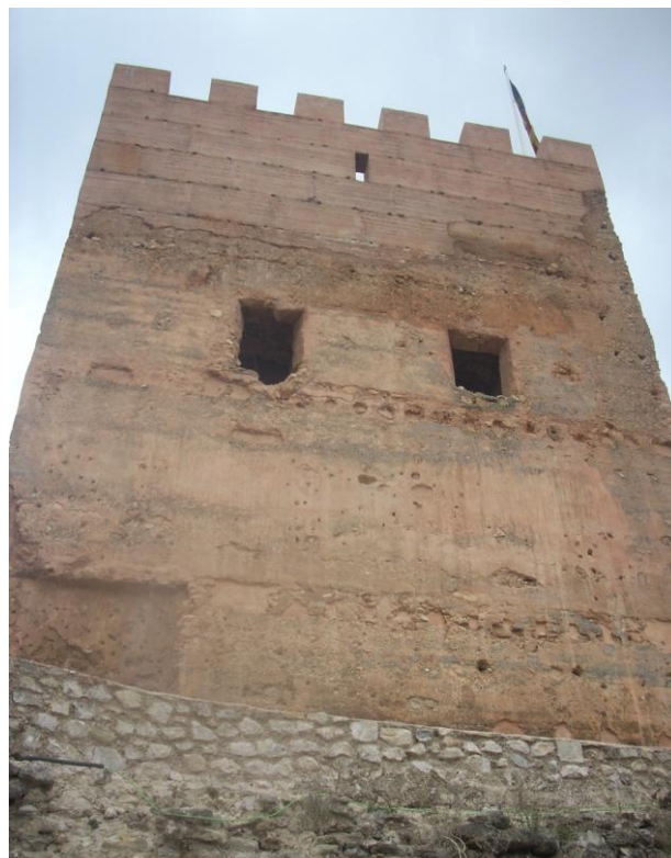
Fotografías cara Norte de la Torre.
