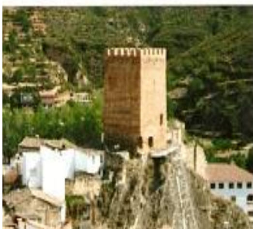
Fotografía cara Sur y Oeste.
