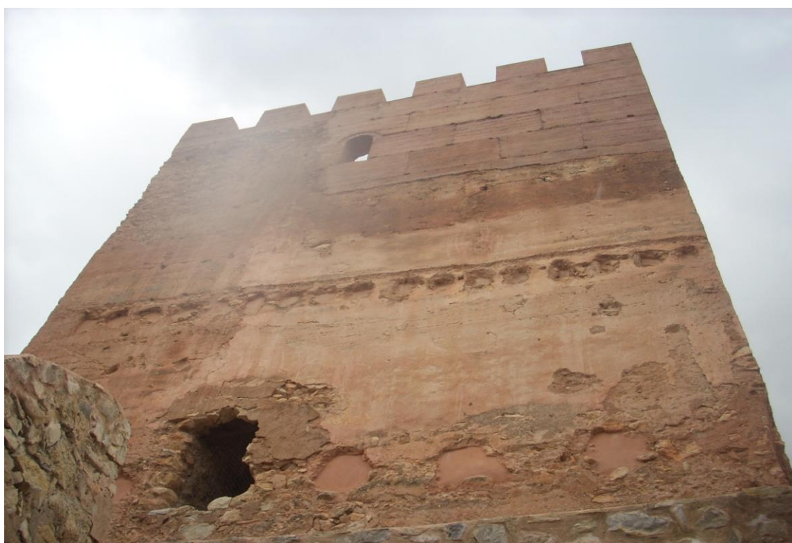
Fotografía cara Sur de la Torre.
