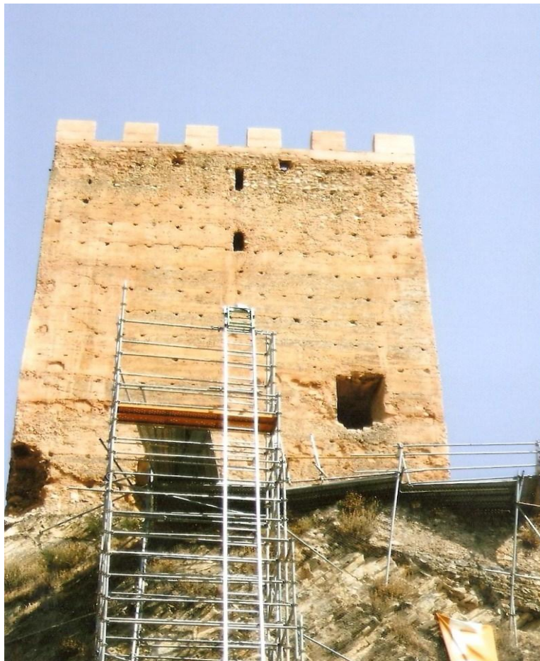
Fotografía cara Sur durante la rehabilitación.
