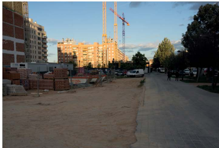
SOLARES EN CONSTRUCCION EN CAMINO MONCADA
