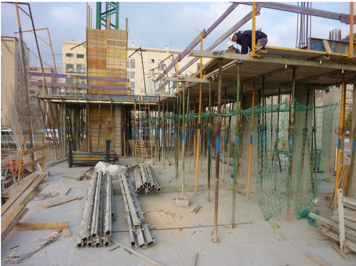
Redes bajo forjado para evitar caída de tableros u otros objetos
