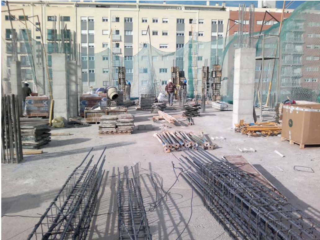
Redes verticales en forjados y losas sin protección de vallado
