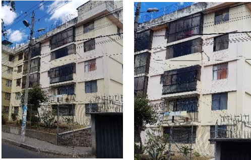
Figura 46. Fotos exteriores – iluminación modificación de ventanas y balcones.
