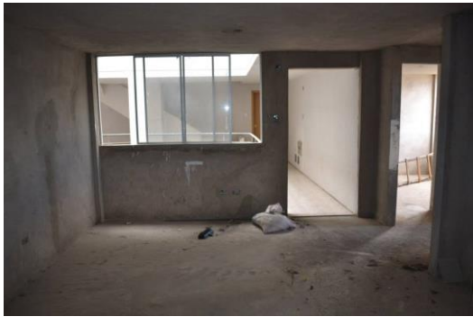
Figura 76. Foto departamento obra gris
