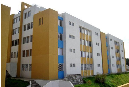
Figura 65. Foto exterior del conjunto
