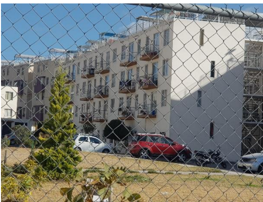
Figura 83. Foto cerco de malla y balcones ocupados como área de secado y trastero.
