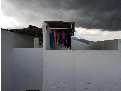
Figura 126. Foto área de lavado y secado Bloque de vivienda 12D
