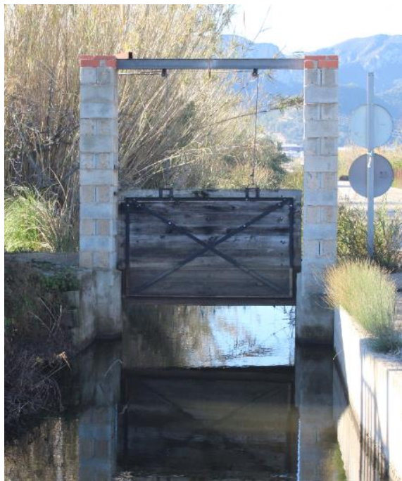
Figura 22. Testellador manual situat en l'encreuament entre la Séquia Travessera i una séquia secundària adjacent. Font: Elaboració pròpia
