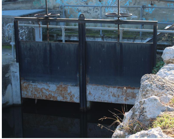
Figura 20. Cano en la Séquia de l'Ahuir al seu pas per la EPSG. Font: Elaboració pròpia
