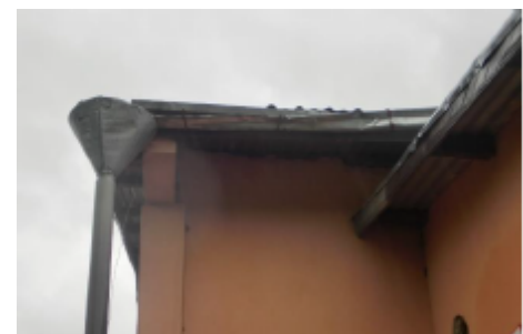
Figure 11. Exemple de captation des eaux de pluies à Nikki. Source: OAN International
