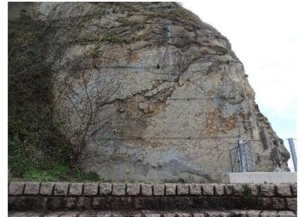
Fig. 2.37: malla metálica dispuesta en la ladera para evitar desprendimientos.
