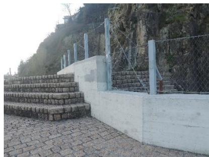
Fig. 2.40: vallado de seguridad interrumpiendo el perfil del graderío.
