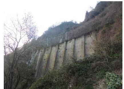
Fig. 2.38: muro de contención de la ladera rematado por el vallado de seguridad.
