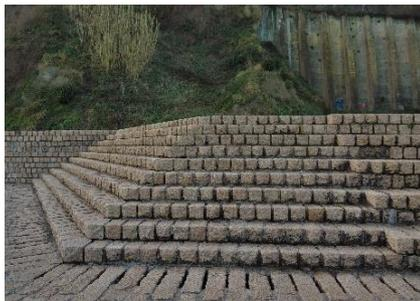
Fig. 2.18: formación de las gradas y escaleras a partir del módulo básico del adoquín.
