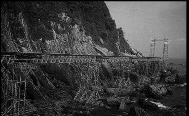
Fig. 2.35: montaje del sistema auxiliar de railes durante la marea baja.
