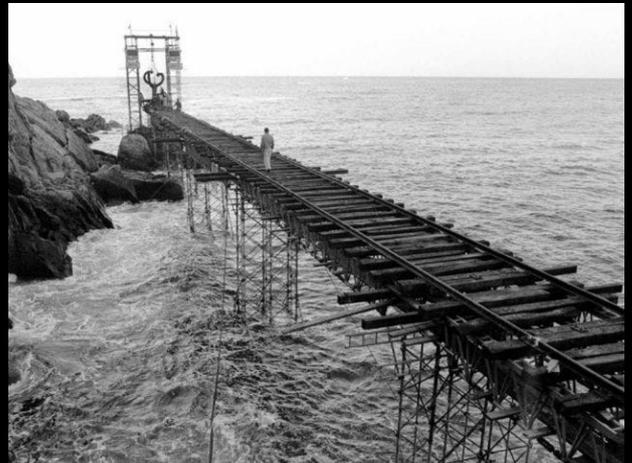
Fig.2.33: sistema de railes instalado sobre el litoral para la implantación de la tercera escultura.
