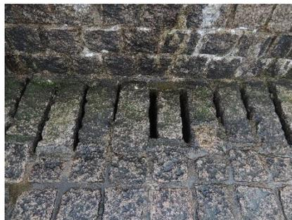
Fig. 2.27: Evacuación de aguas en la base de las gradas.
