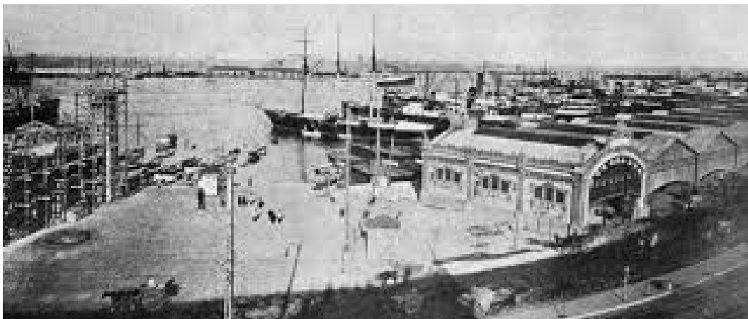
Fig 25 | Fotografía aérea de Los Tinglados del Puerto de Valencia.
