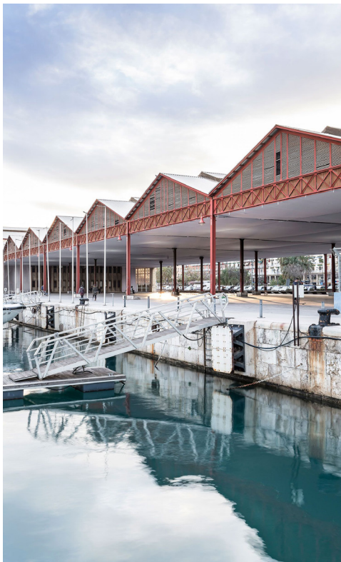
Fig 22| Fotografía actual de Los Tinglados del Puerto (Tinglado numero 2)
