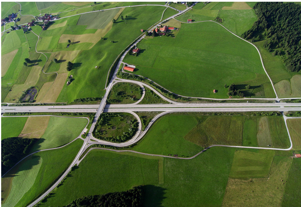
Fig. 17 | Bundesautobahn 7, Ausfahrt 138 "Nesselwang" (Alemania). Autor: Softeis.
