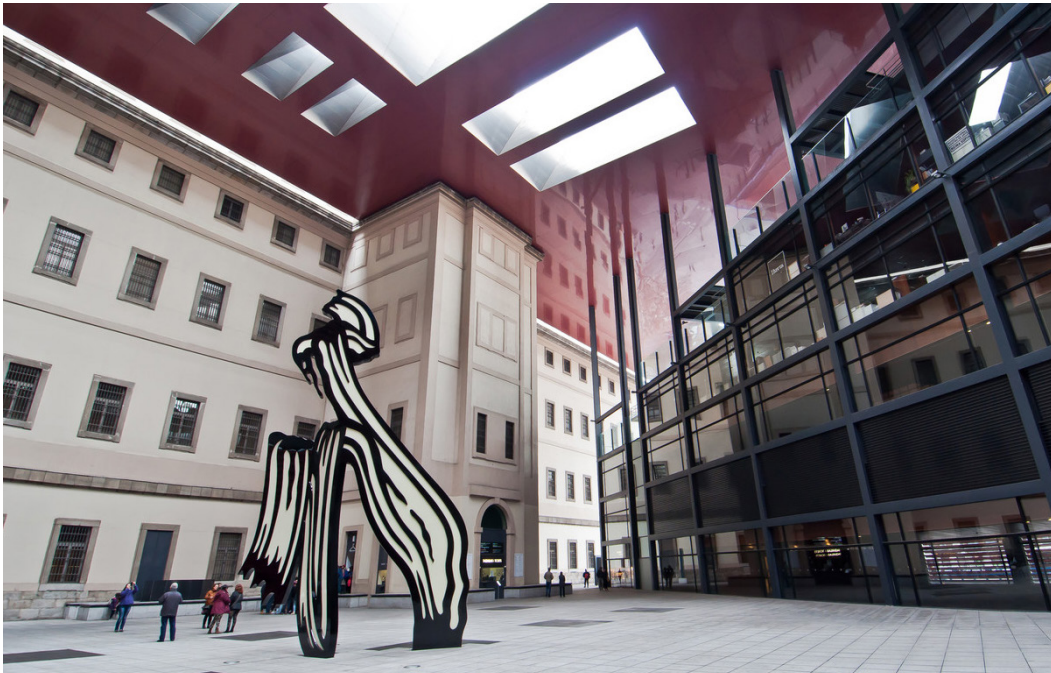
Fig 3|Fotografía de la ampliación del Museo de Reina Sofía realizada por Jean Nouvel en Madrid.
