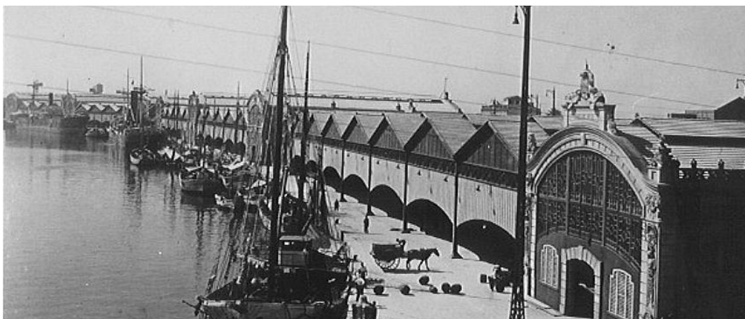
Fig 26 | Fotografía aérea de Los Tinglados del Puerto de Valencia.
