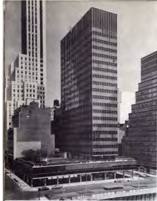
Figura 17. Edificio Lever House de SOM
