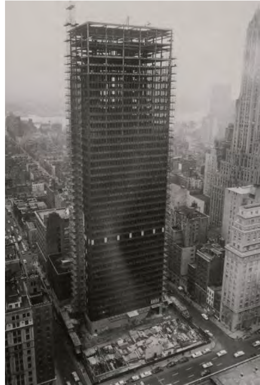
Figura 25. Edificio Seagram diseñado por Mies Van der Rohe ubicado en Park Avenue
