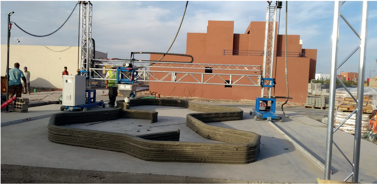
Figure 2. Early stage of construction. 2019. ©Be More 3D / Figura 2. Comienzo de la construcción. 2019. ©Be More 3D.
