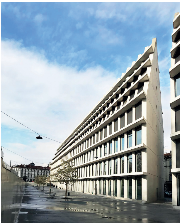
Figure 7. Fondazione Feltrinelli Porta Volta, Herzog & de Meuron. 2013. ©Paolo De Marco / Figura 7. Fondazione Feltrinelli Porta Volta, Herzog & de Meuron. 2013. ©Paolo De Marco.
