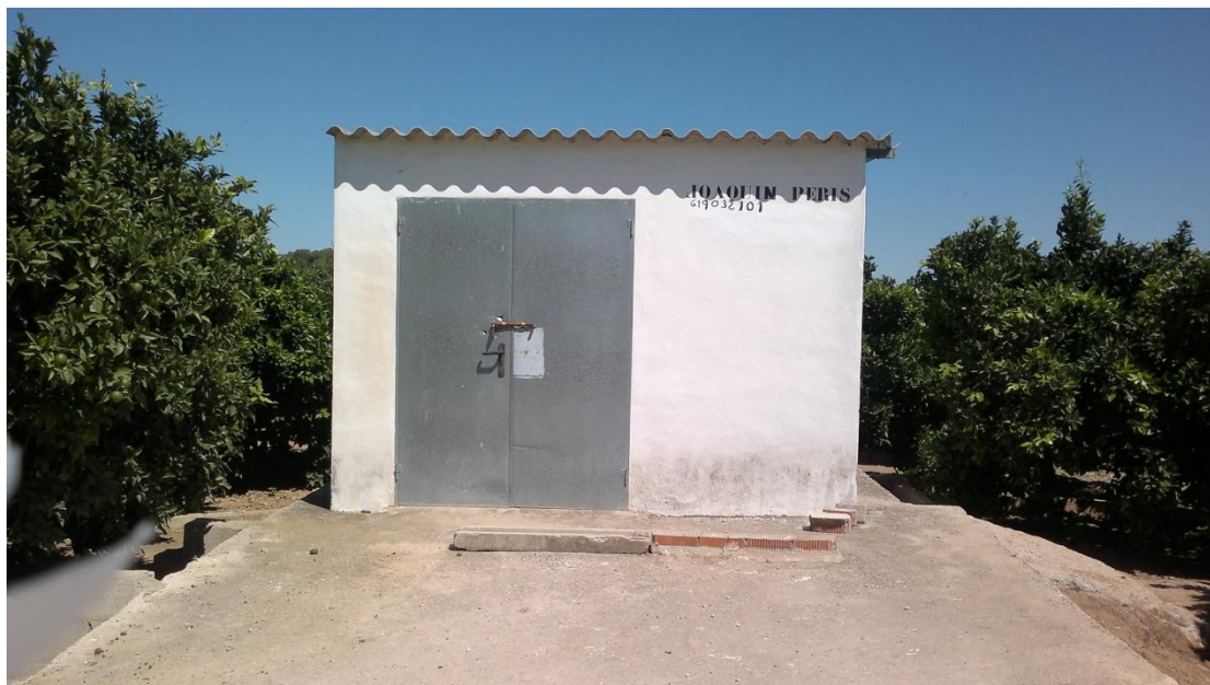
Foto15.- Fotos de las dos Casetas a Reformar, que se emplearán como almacenes para los Huertos Ecológicos
