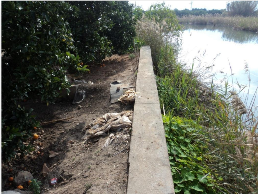
Foto8.- Muro de contención artificial en la zona Este del Ullal
