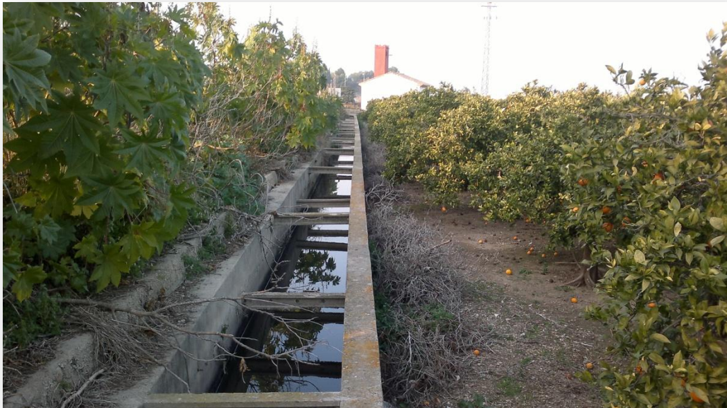
Foto9.- Acequia que controla el nivel freático de la zona de estudio, pasa por el lado izquierdo del Ullal Gran
