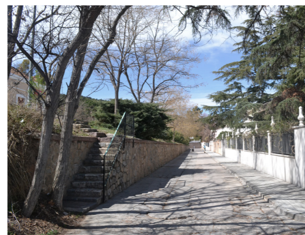
Mur que conté el terreny de la parcel·la de l'estació.
