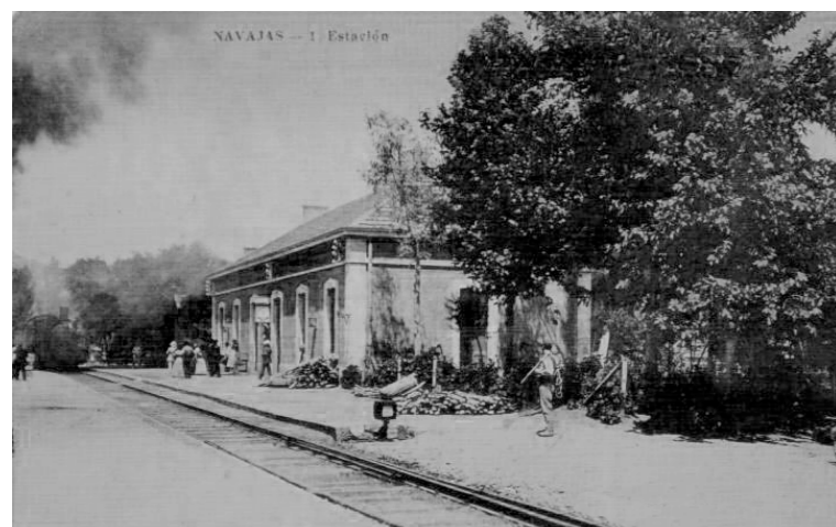
Estació amb les vies a cota de l'entrada.
