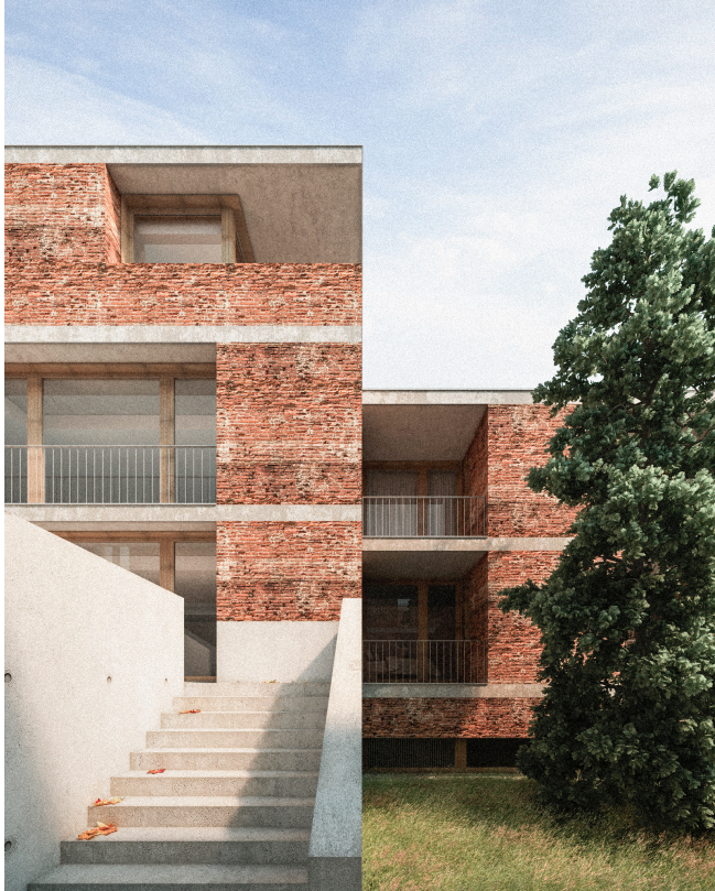
Escalera exterior frente al alzado Sur del Módulo 3
