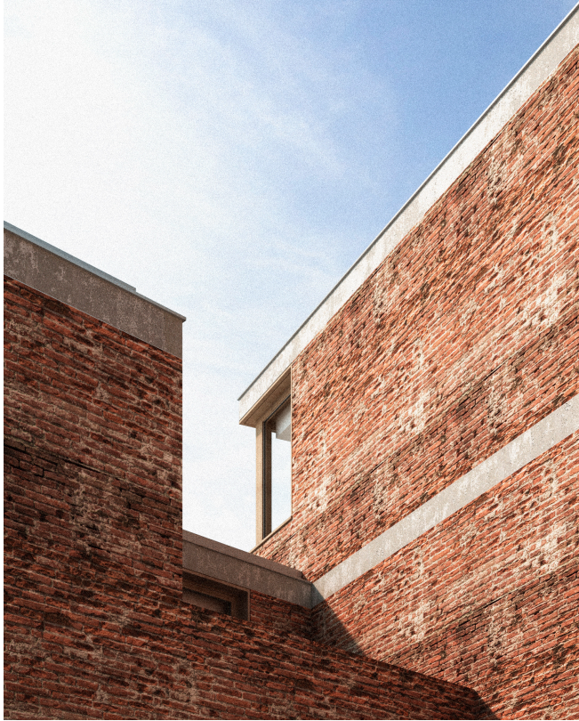
Detalle de una ventana del Módulo 2
