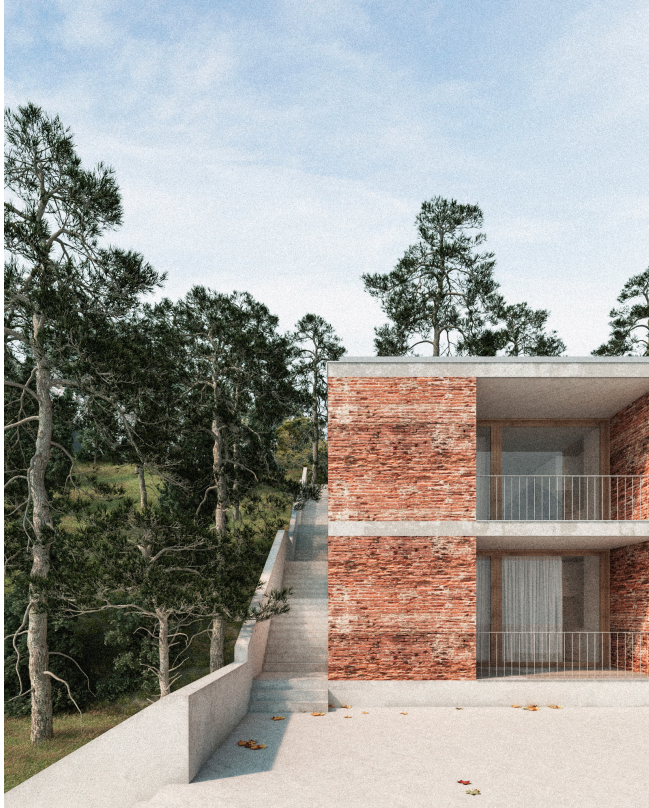
Escalera exterior junto al Módulo 1
