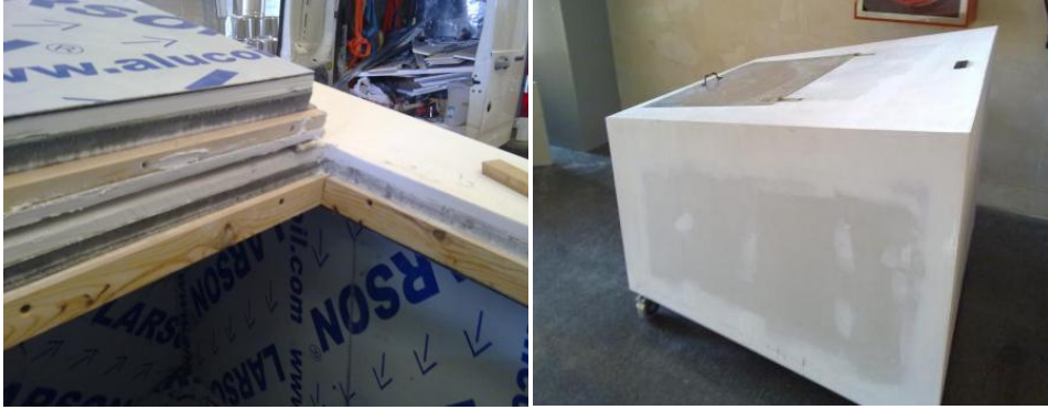
Fig. 29. Detalle compuerta y cámara terminada.
