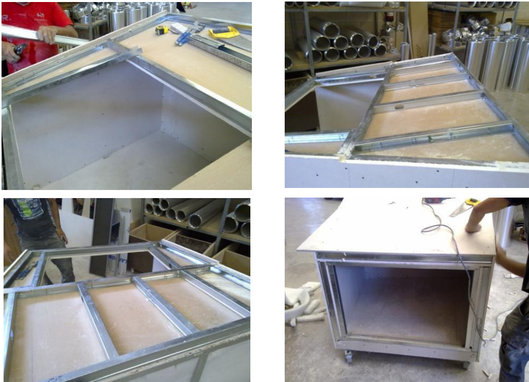
Fig. 26. Detalle montaje del bastidor para la puerta.
