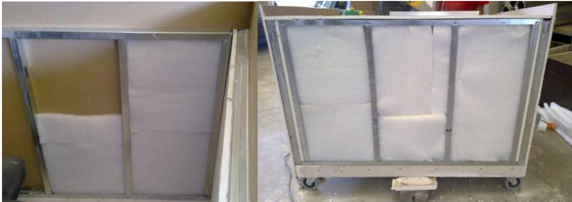
Fig. 23. Detalle colocación de la lana de poliéster.
