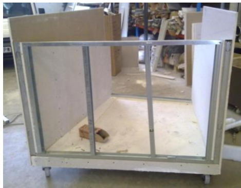
Fig. 20. Construcción de la cámara reverberante a escala
