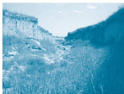
Figura 2d: Vista de la Cárcava Corralito, 15 Km aguas debajo de la cabecera, 2005.
