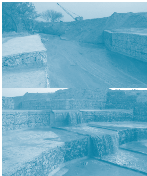
Figura 20. Reparación realizada en el canal de aducción a la obra.
