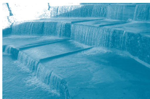
Figura 14. Obra en funcionamiento para caudales bajos.
