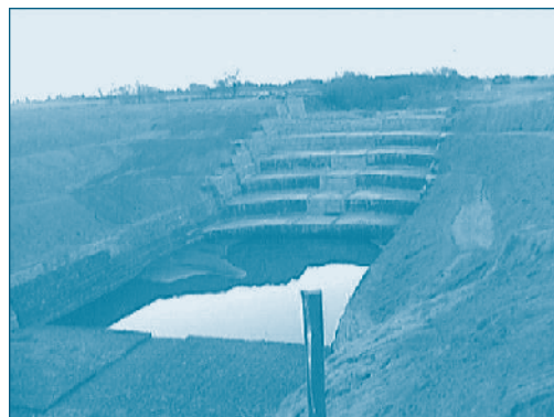
Figura 13. Obra concluida, Junio de 2003, cada salto vertical es de 2,3 m (notar en la margen derecha del cuenco de disipación la sedimentación por aporte lateral).
