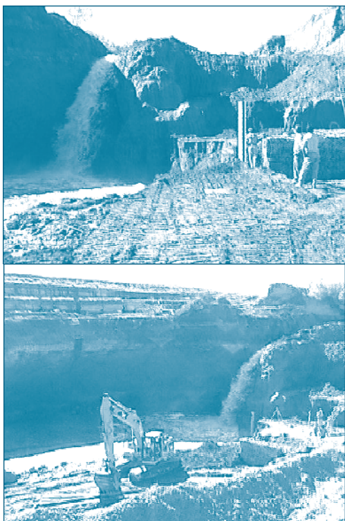
Figura 12. fotografías del desvío del arroyo por zona de obra (Diciembre de 2002).
