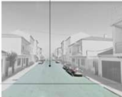
Imagen actual calle Alfonso XII. Tramo cruce con colegio.
