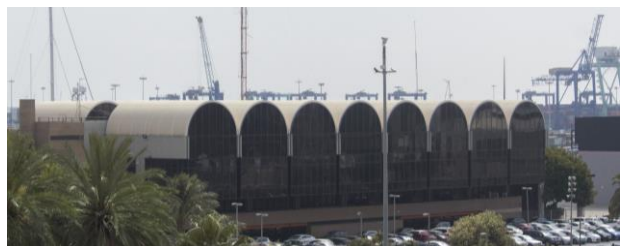
Fig. 2. Fachada Suroeste de la AEM. Elaboración propia.
