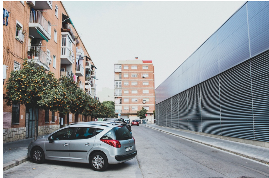
Imagen 34. Vista del acceso al colegio Jesús-María desde la calle casa de la misericordia. Fuente: Elaboración propia.
