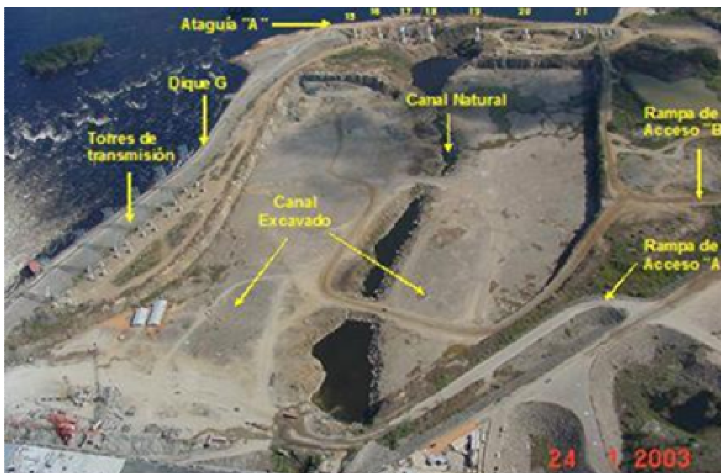
Figura 3. Vista del canal de descarga previo a la inundación (Enero 2003)
