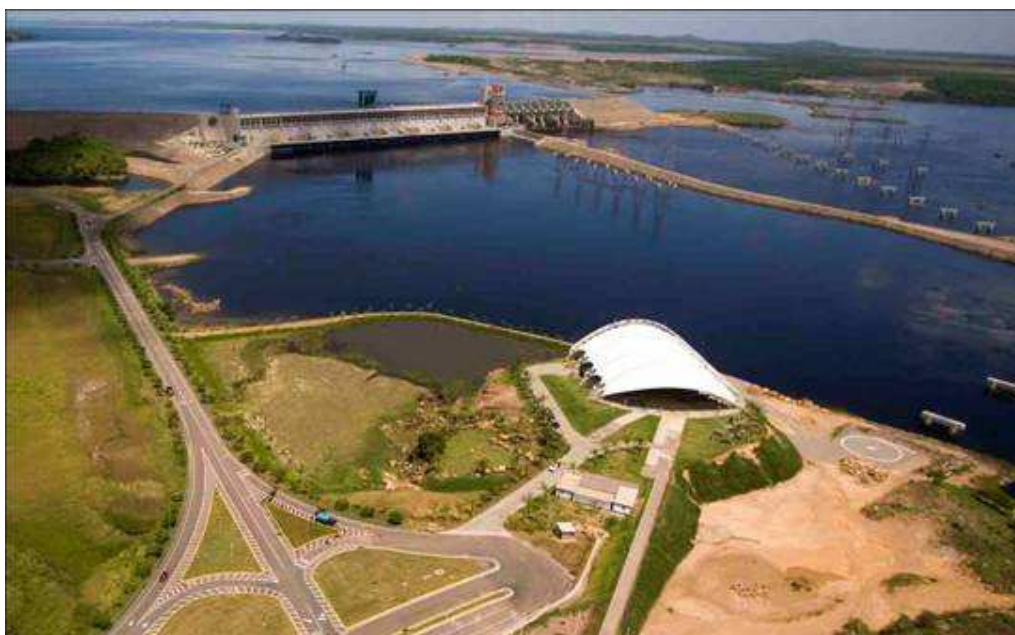
Figura 2. Vista aérea de la Central Hidroeléctrica de Caruachi
