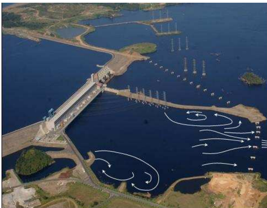
Figura 7. Líneas de corriente observadas en el prototipo
