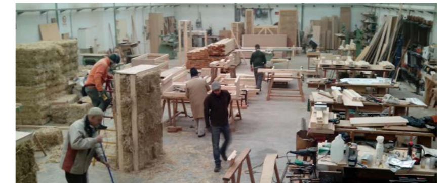
Fig. 16 Taller de prefabricación de paneles. Constructora Okambuva.
