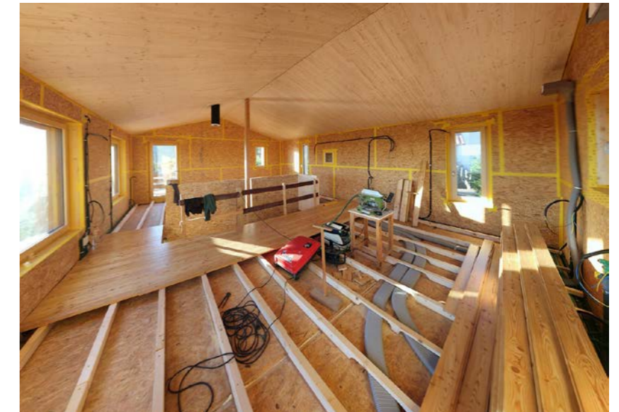
Fig. 60 Proceso constructivo en el interior
