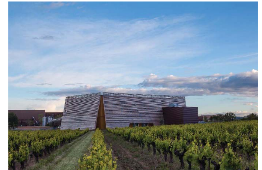
Fig. 47 Exterior Salle Polyvalente
