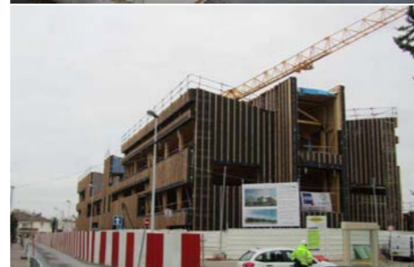
Fig. 37 Proceso constructivo fachadas
