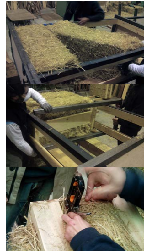
Fig. 15 Proceso de ejecución de los paneles prefabricados. Constructora Okambuva.
