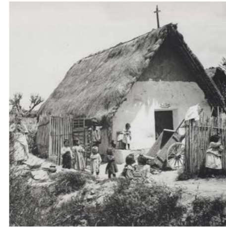
Fig. 1 Barraca Valenciana. Ejemplo de cubrición de cubiertas con paja.
