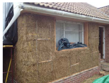
Fig.11 Vivienda unifamiliar tratada con el sistema wrapping. Inglaterra.
