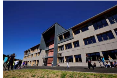
Fig. 30 Exterior Cité Scolaire
