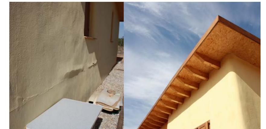
Fig. 67 (Izq.) Detalle del encuentro entre sobrecimentación y fachada Fig. 68 (Der.) Detalle de la cubierta
