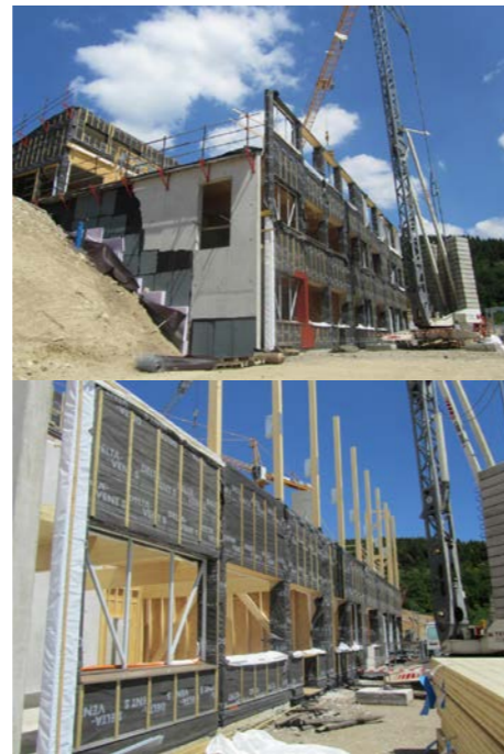
Fig. 31 Proceso constructivo Cité Scolaire
