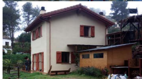
Fig. 8 Casa de paja con técnica Greb, Corbera de Llobregat, 2011-2013.
