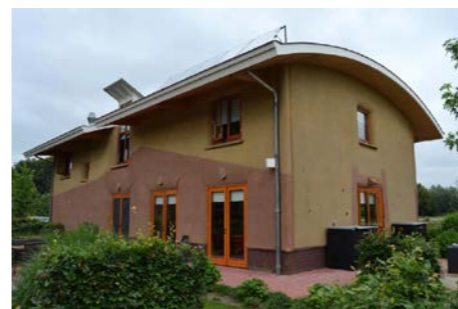
Fig. 10 Hotel situado en Haps, Países Bajos mediante el sistema CUT.
