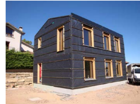
Fig. 59 Colocación de las fachadas
