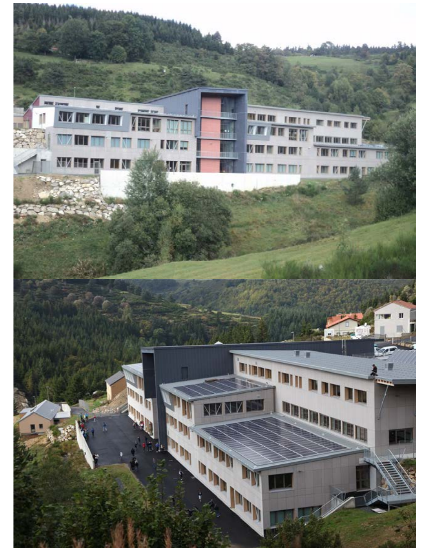
Fig. 32 Exterior Cité Scolaire
