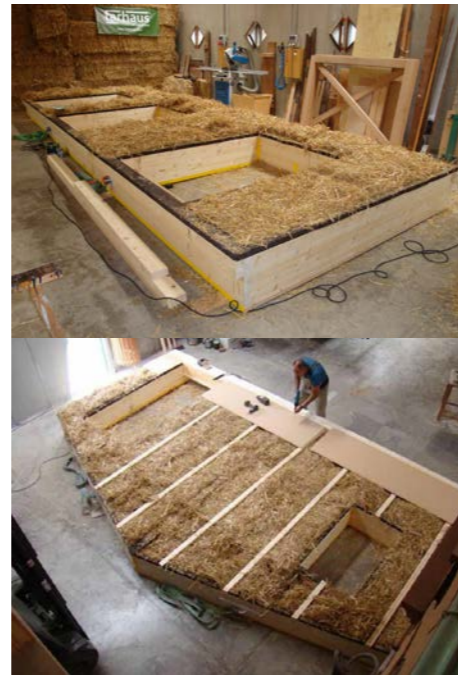
Fig. 58 Proceso constructivo fachadas
