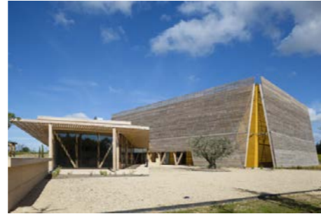
Fig. 43 Exterior Salle Polyvalente
