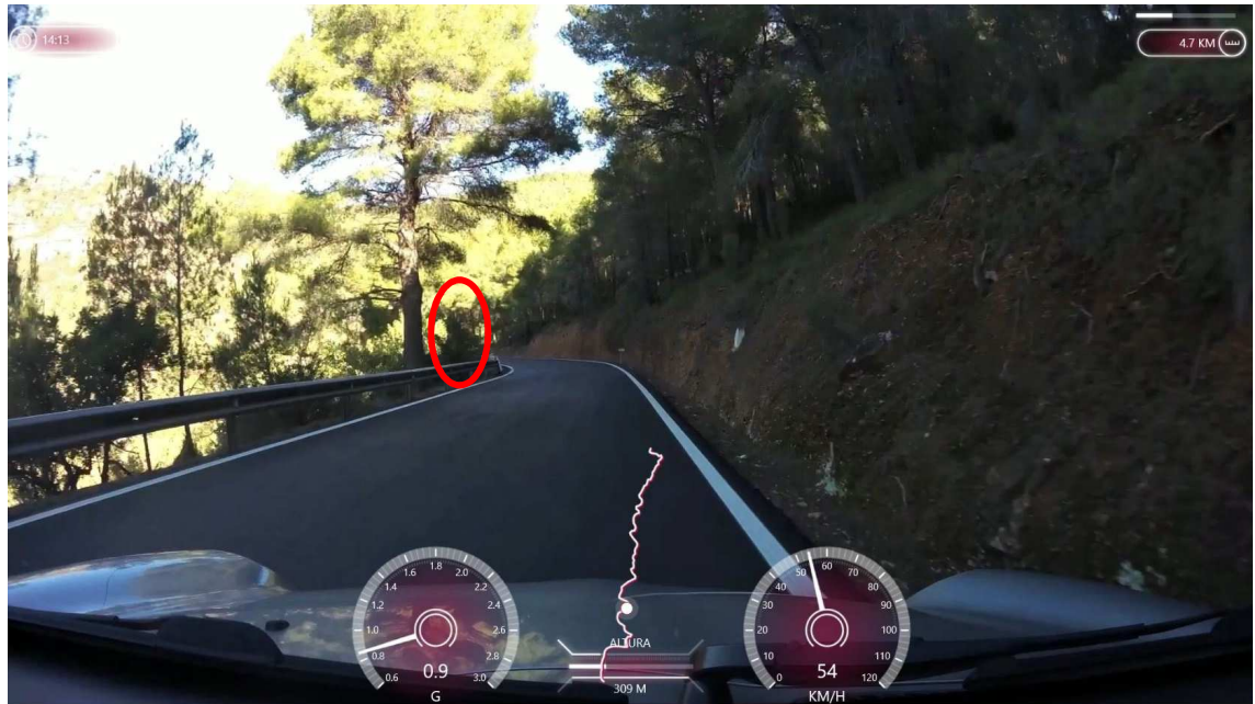
Ilustración 95. CV-25 en P.K. 11+480, sentido creciente de PP.KK. Recorte vegetal de la masa indicada en la imagen para mejora de la visibilidad.
