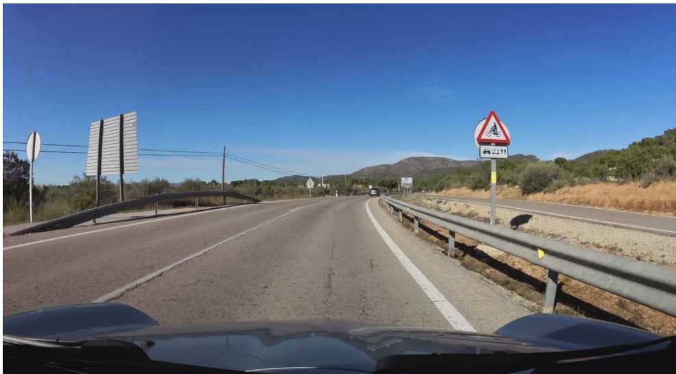
Ilustración 38. Señalización de advertencia sobre la circulación de ciclistas en el tramo. P.K. 7+025.
