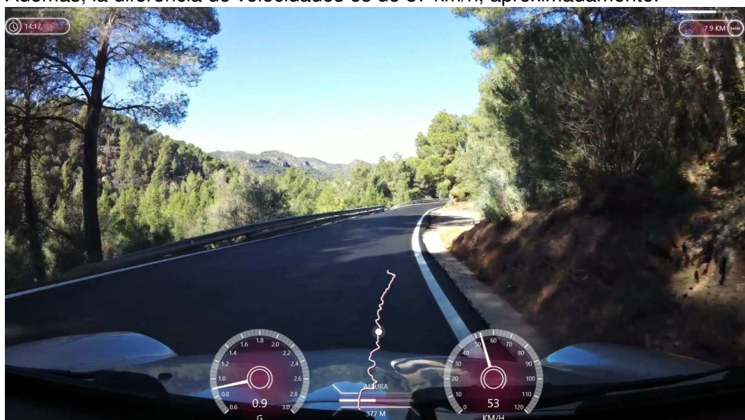
Ilustración 101. CV-25 en P.K. 14+600, sentido creciente de PP.KK. Apartadero propuesto por margen derecha.
