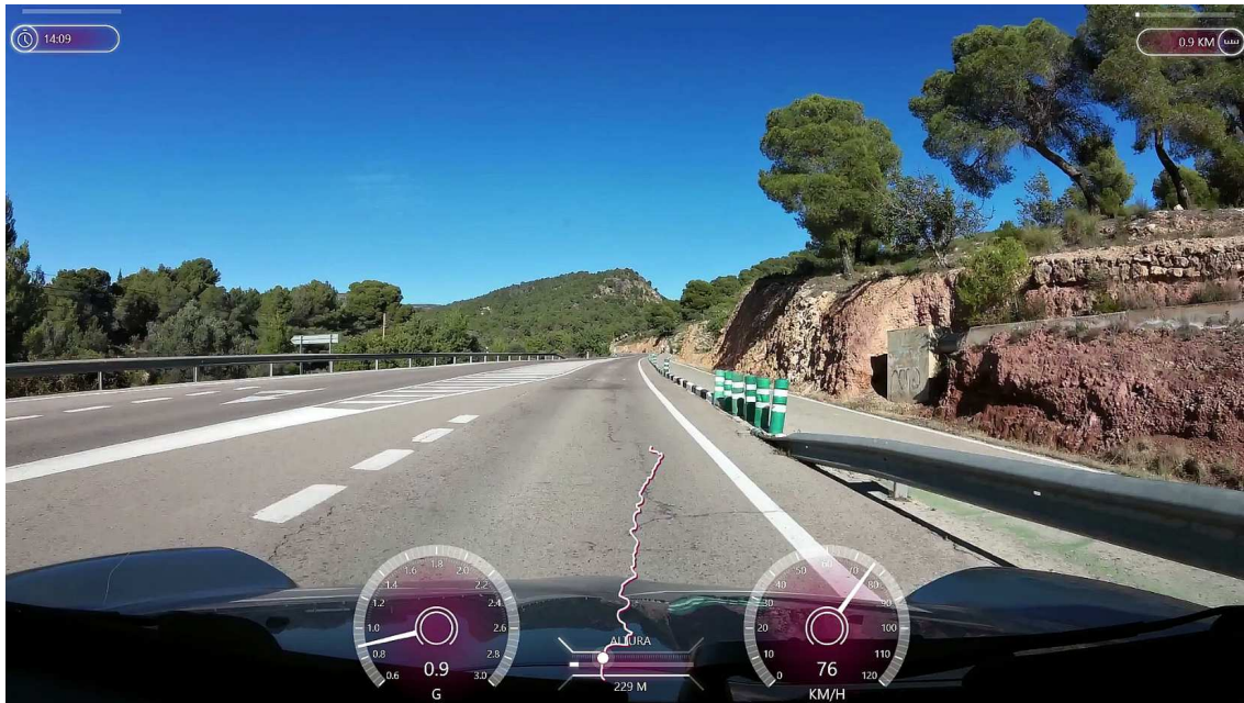
Ilustración 84. CV-25 en P.K. 7+845. Vía auxiliar adosada a vía principal.
