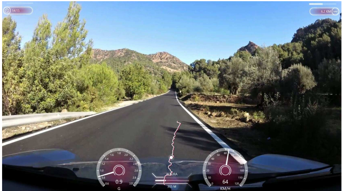
Ilustración 98. CV-25 en P.K. 12+900, sentido creciente de PP.KK. Apartadero propuesto por margen derecha.
