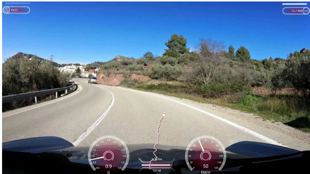
Ilustración 109. CV-25 en P.K. 19+350, sentido creciente de PP.KK.
