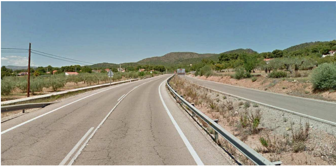
Ilustración 81. CV-25 en P.K. 7+075. Calzada principal y calzada accesoria.
