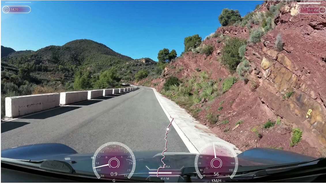
Ilustración 58. CV-25 en P.K. 17+550. Recorrido “Calle del Calvario, 13 – Climb” en sentido ida. Inicio del tramo en ascenso a media ladera.
