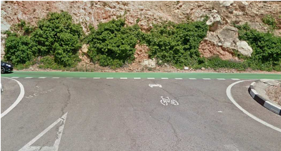
Ilustración 83. CV-25 en P.K. 6+930. Salida hacia calzada accesoria desde glorieta.
