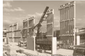
CENTRO DE NUEVAS TECNOLOGÍAS DE GALICIA, PRYTHANUSO (CONSTRUCCION)
