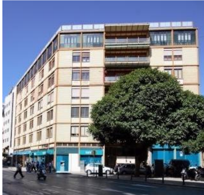
Ilustración 1. Colegio Mayor de La presentación y de Santo Tomás de Villanueva. CTAV. “Guía de Arquitectura de Valencia”. Valencia, 2007.
