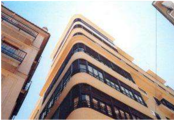
Figura 13. Edificio Cánovas vista a pie de calle
