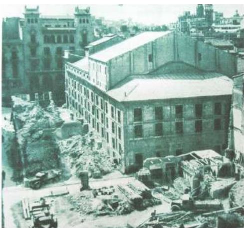
Figura 42. Obras de demolición de la manzana colindante
