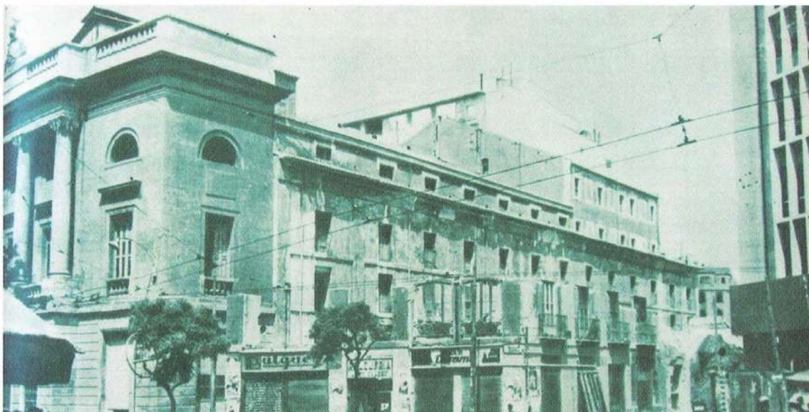
Figura 41. Derribo de la manzana colindante recayente a la calle Poeta Querol
