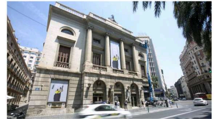
R. Vista Diurna
