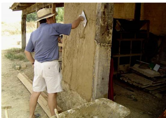
tipo y grosor de la trama que sea necesario cubrir. Por este motivo el uso de esta técnica suele venir acompañado de protecciones complementarias, capaces de minorar el efecto de las aguas de lluvia, o la absorción del paramento, tales como la disposición de aleros en cubierta o la aplicación de revoques o encalados en el paramento para conseguir aumentar su durabilidad.
