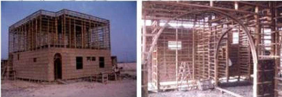
**CONSTRUCCIONES REALIZADAS MEDIANTE LA TÉCNICA DEL BAJARAQUE INDUSTRIALIZADO**
