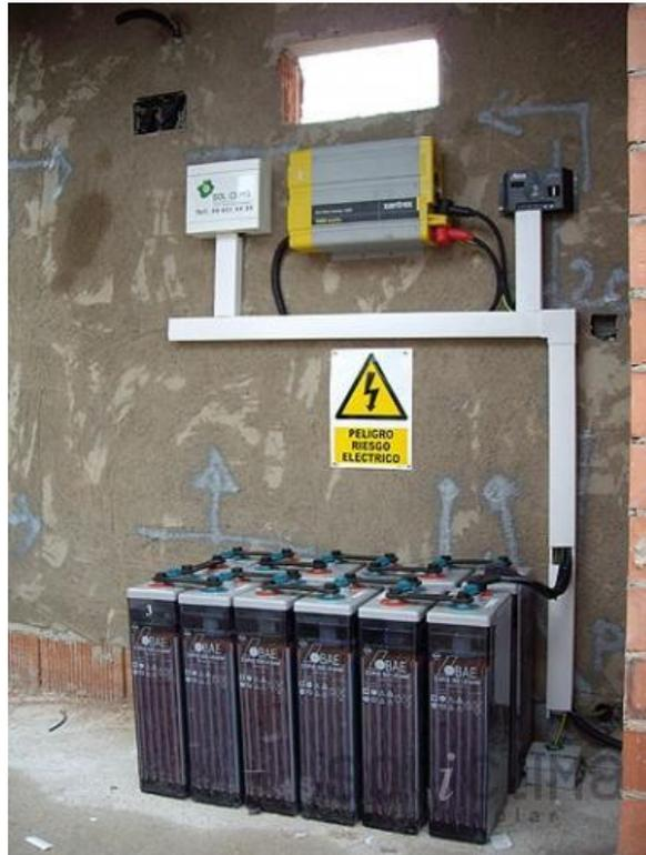
*Ilustración 40: Ejemplo de baterías en una instalación aislada fotovoltaica*
