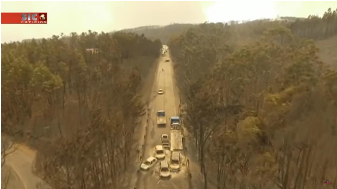
Imagen 19. Carretera N236-1, bautizada como "carretera de la muerte".
