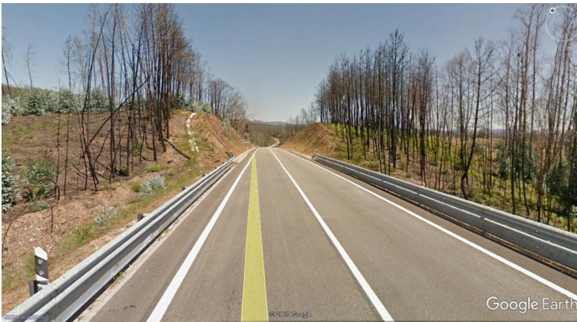
Imagen 21. Carretera NE 236-1 a la altura del paso de la deflagración. Foto actual (2019).
