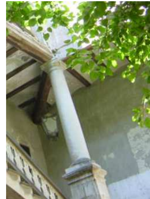
Columna del patio antes de su intervención.
