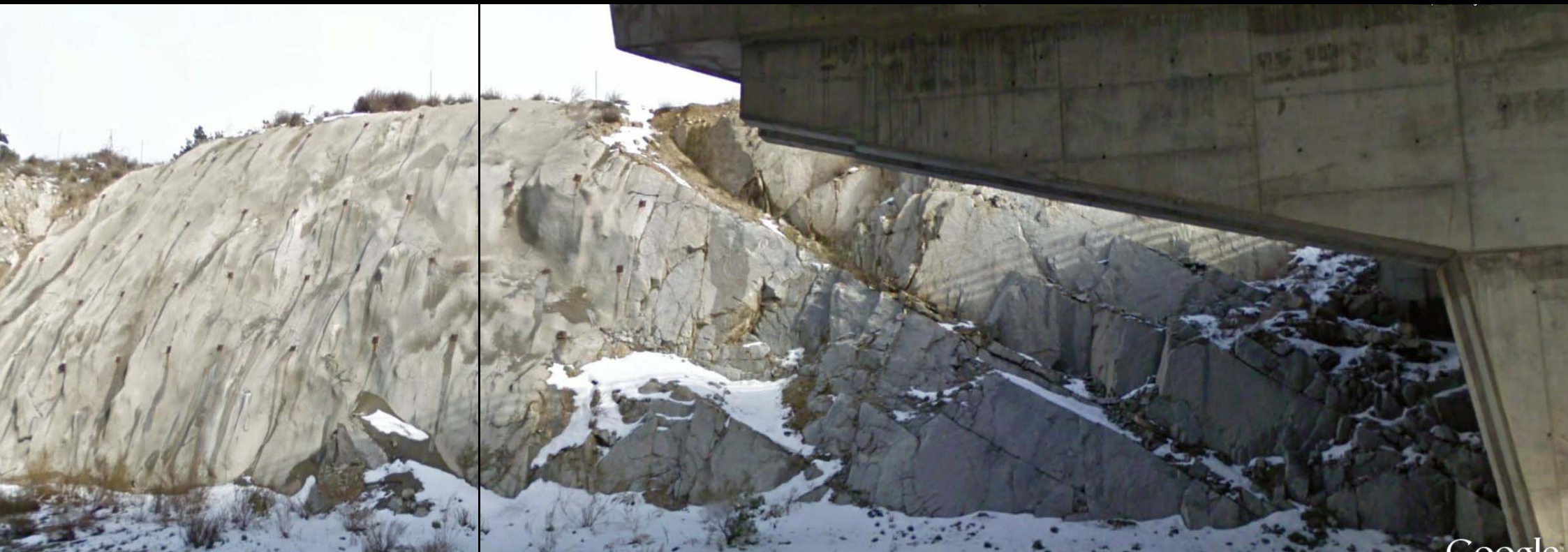
Cruce de vías en zona de adamellitas –granitos con cordieritas de grano grueso. Afloramiento con mallazo, bulones y gunitado de protección. SE de Los Angeles de San Rafael. NE Hoja de El Espinar.
