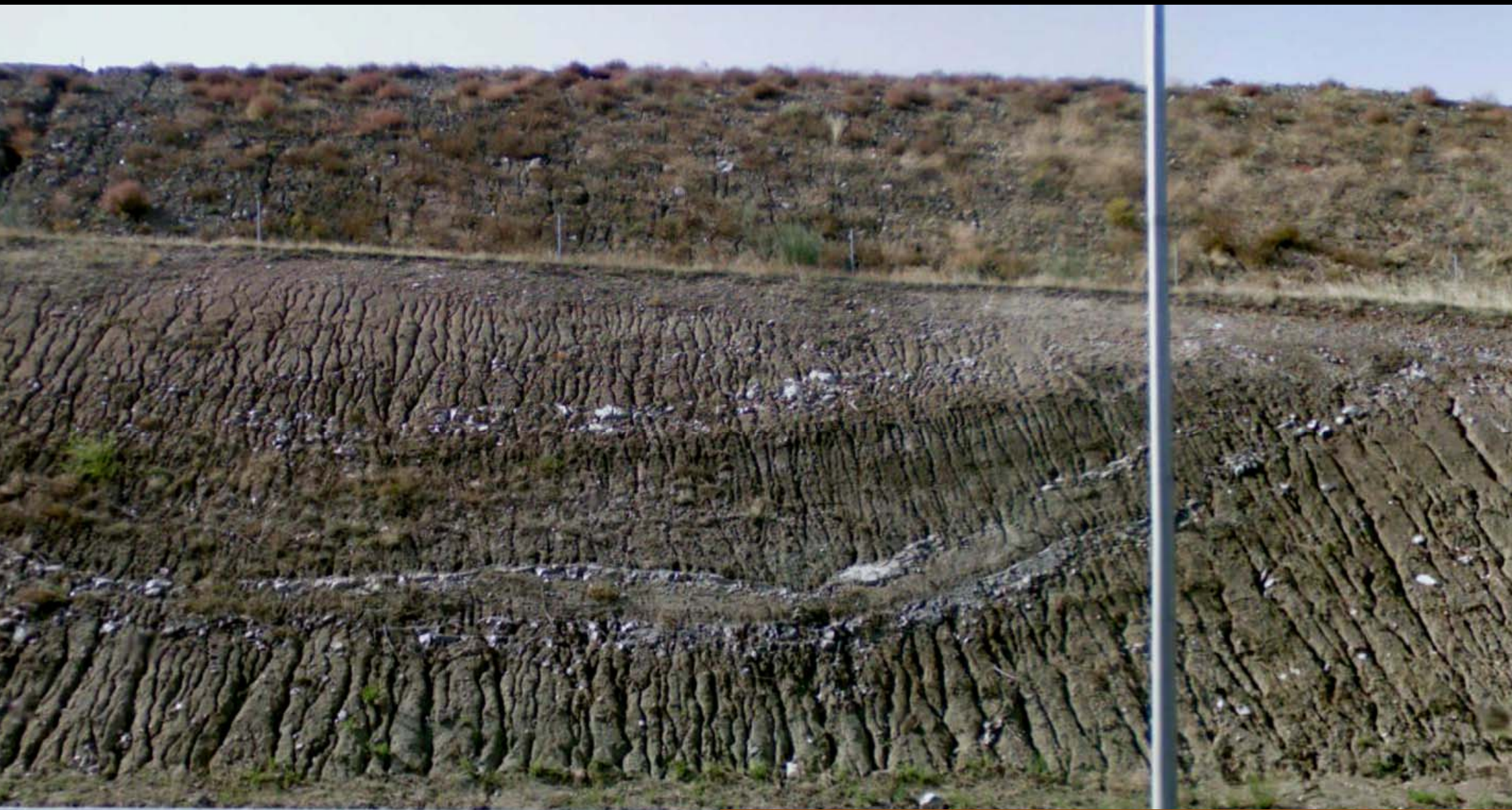
Desarrollo de cárcavas en terrenos de yesos blancos con arcillas verdosas. Aragoniense Inf. Mioceno Med. Terciario. En Autopista M-50. S de San Fernando de Henares E Hoja de Madrid.
