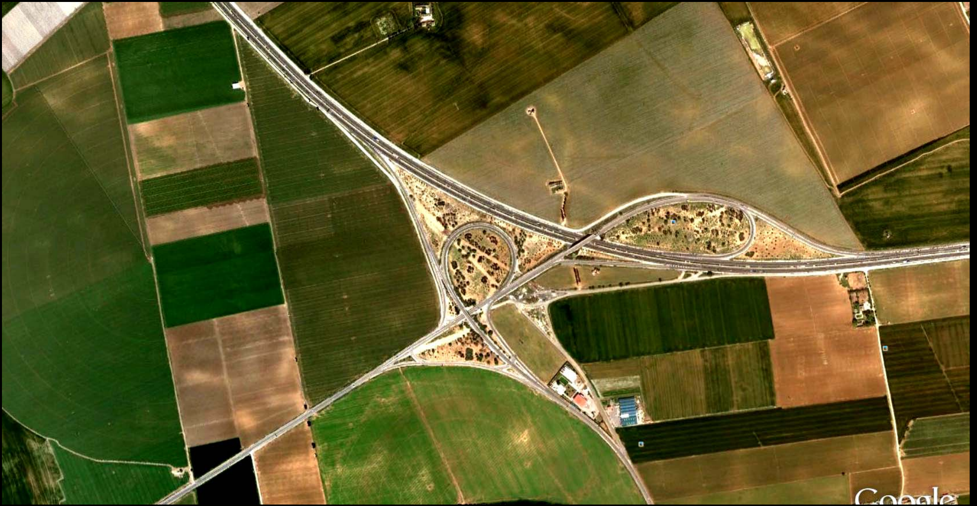
Enlaces en la Autovía A-92. Centro SE Hoja de Antequera.
