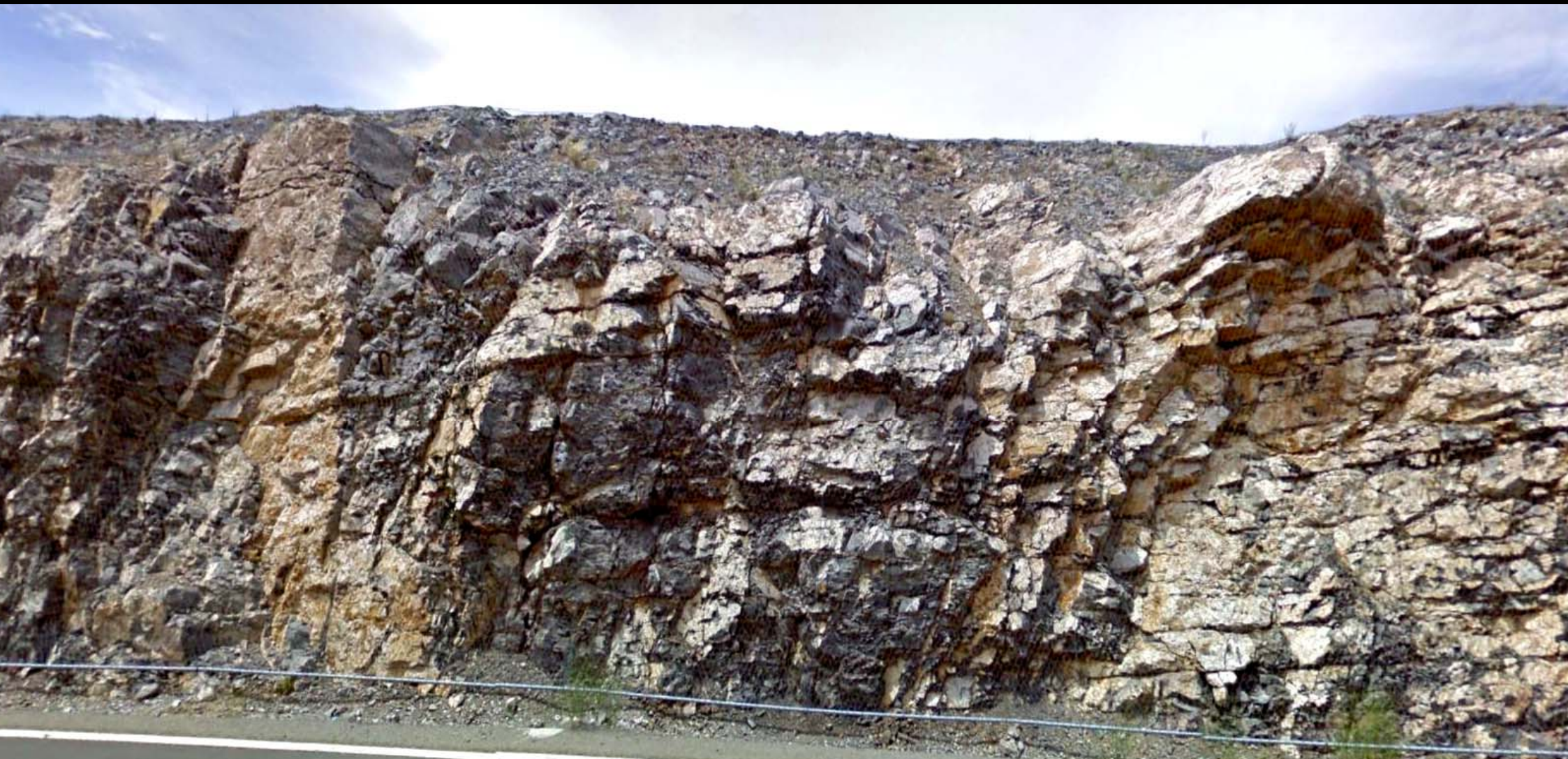
Calizas y dolomías tableadas del Liásico. Jurásico Inf. NE de Corbalán, E Hoja de Teruel. Mallazo de protección
