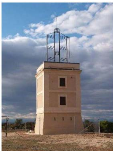
Imagen 8. Sistema de telegrafía óptica española (Sistema Mathé de mediados del s. XIX). Torre de Arganda y maquinaria con las posiciones del marcador. En este sistema cada combinación de los dos marcadores correspondía a un mensaje cifrado gubernamental, del tipo "Se han disuelto las Cortes" o "Ha nacido un heredero al trono".
