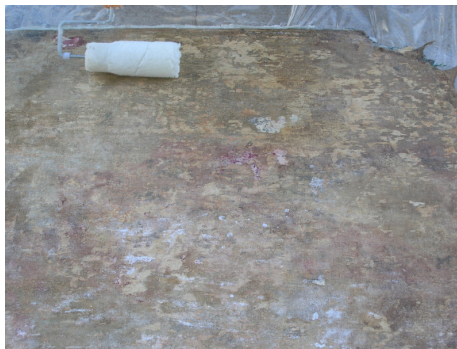
Aplicación de Beva-371 por el reverso
