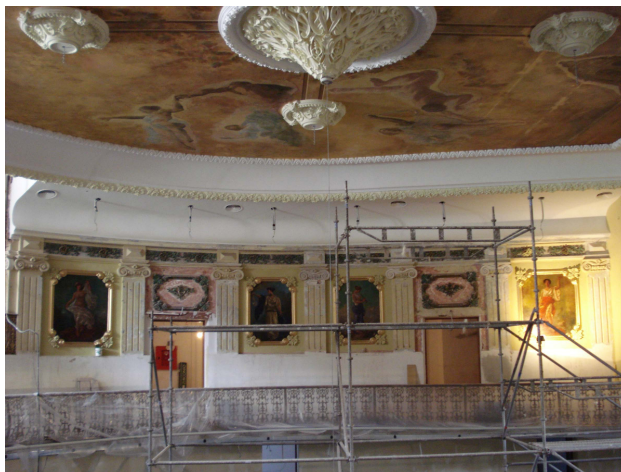
Ubicación de las obras en su espacio arquitectónico definitivo tras la intervención
