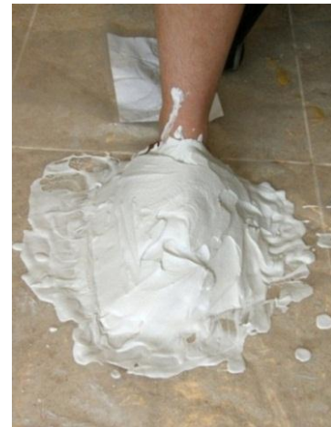
Fig. III. 10. Proceso de trabajo, 2011. Aplicación de la escayola.
